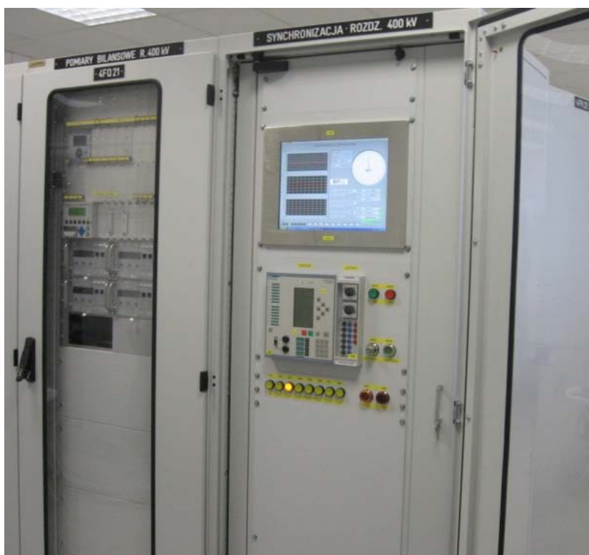
Rys. 2. Szafa systemu nadzoru pracy układów wypowskich
